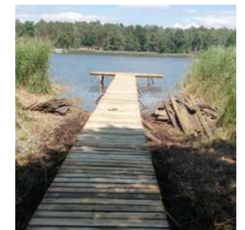
Fertiggestellter Steg am Brettmühlenteich Zschorna
