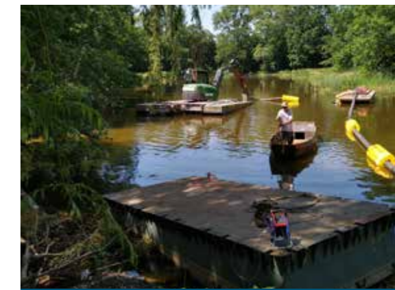
Saugbagger im Einsatz am Alten See in Glaubitz
